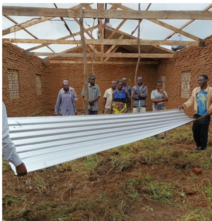
De metalen golfplaten voor het dak worden binnengedragen
