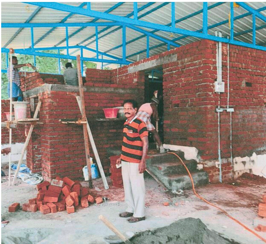
De renovatie van de pastorie in volle gang
